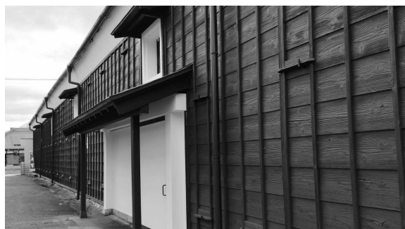
図1 醤油仕込み蔵の外観
