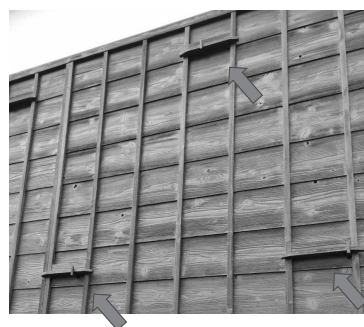
図2 仕込み蔵の杉板外装の留め
